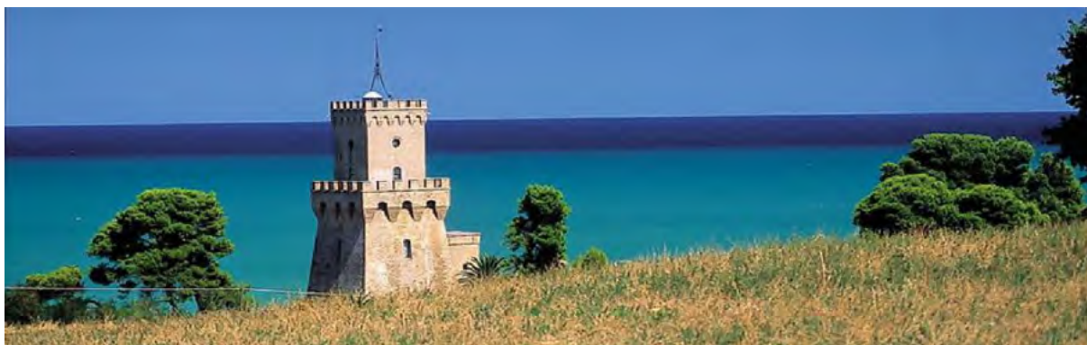
Foto 1. Sede dell'Area Marina Protetta Torre del Cerrano (TE).
